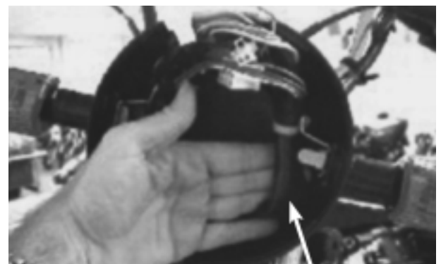
Puxar a fiação principal para dentro da carcaça e mantê-la encostada à parede interna esquerda
